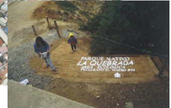
Construcción del Parque.
